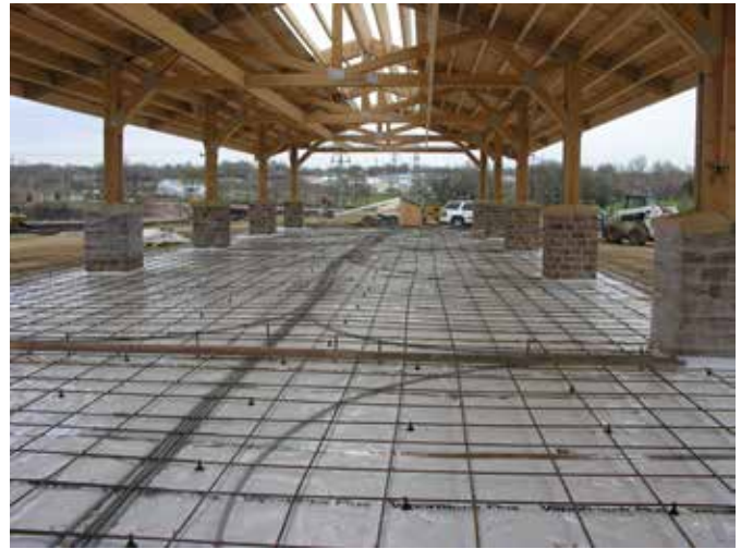
Under-Slab Vapor/Gas Retarder
