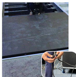
箱体安装，线材连接
