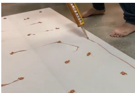
04 Apply the Liquid Nail glue on the back of PVC Marble Sheet 在PVC大理石板背面涂上免钉胶。
