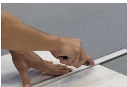
03 Cut the PVC Marble Sheet 按照所需的尺寸，切割PVC大理石板。
