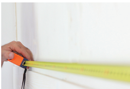
01 Measure the wall 请用卷尺测量墙壁，计算出安装面积和需要多少块石板
