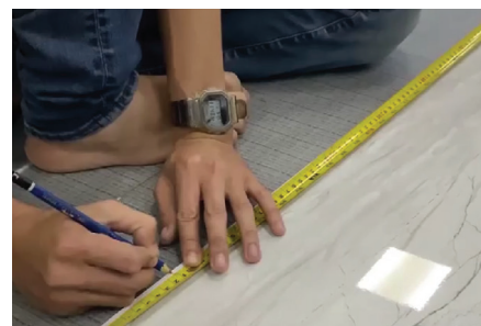
02 Marking On PVC Marble Sheet 在PVC大理石板上，画下尺寸
