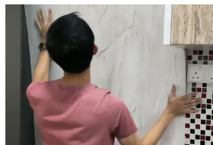
05 Installing PVC Marble Sheet on Wall 在根据墙上所留下的尺寸，把PVC大理石板安装在墙壁上。
