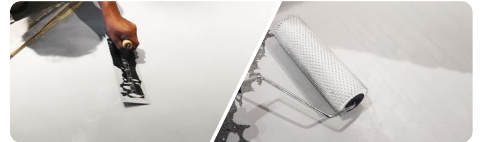
STEP 2 : MOISTURE BARRIER
