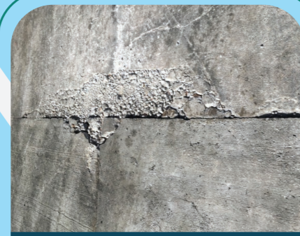
Spalling
