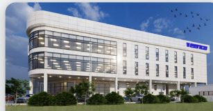
Veenco Switchgear Perai
